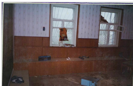
Ремонт внутри помещения
